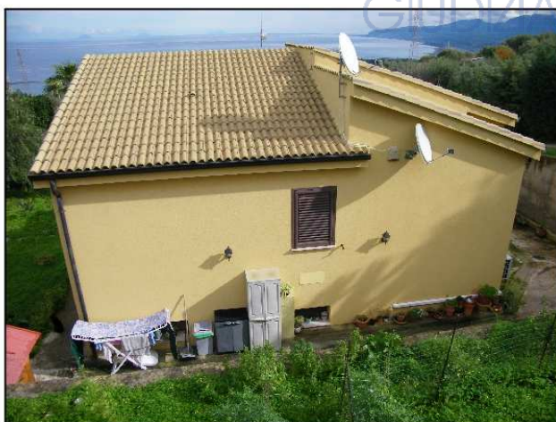
Foto 3. Prospetto S.O. dall'alto della strada
