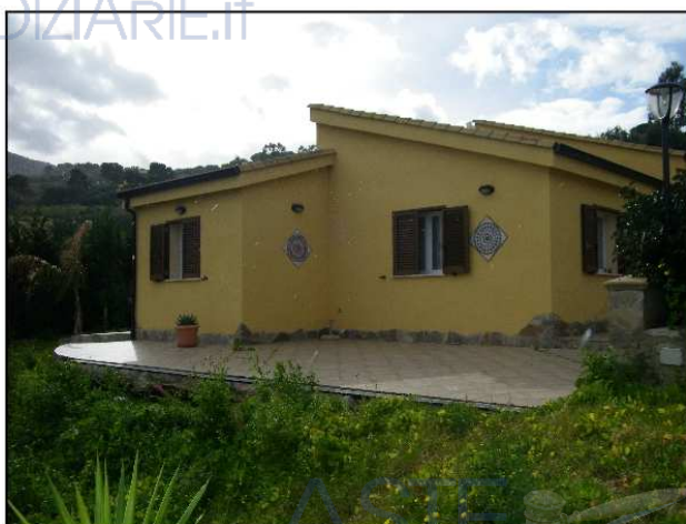
Foto 4. Prospetto N.E. visto dal giardino
