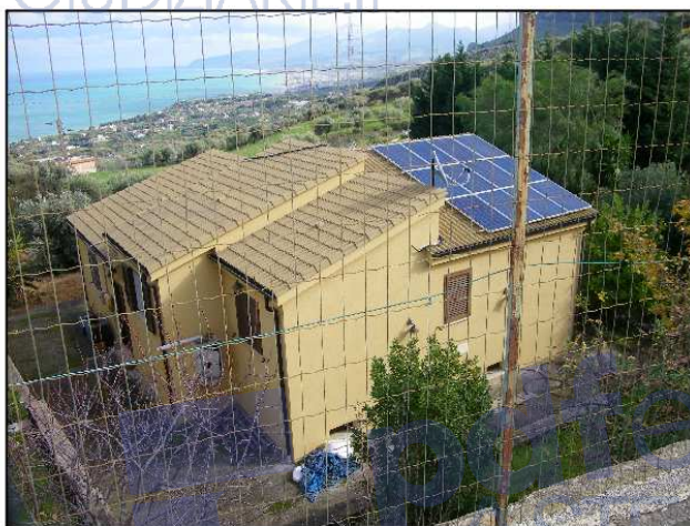
Foto 2. Prospetti S.O. e N.O. visti dall'alto della strada
