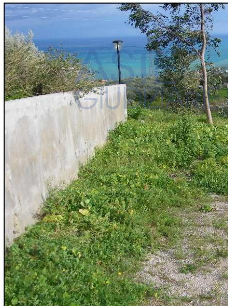
Foto 8. Muro di confine ad ovest del lotto
