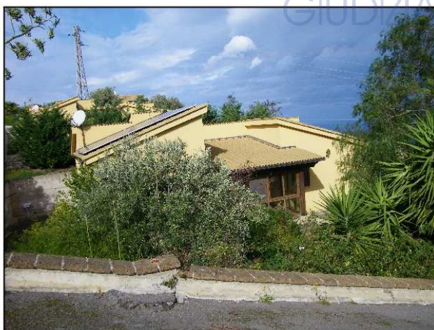
Foto 3. Prospetto S.E. visto dalla rampa di accesso
