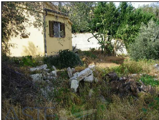
Foto 9. Area del terreno franato
