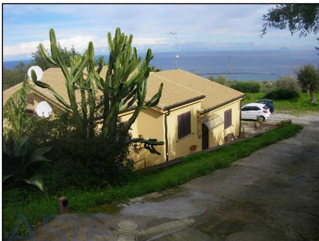
Foto 5. Prospetto S.E. visto dalla rampa di accesso
