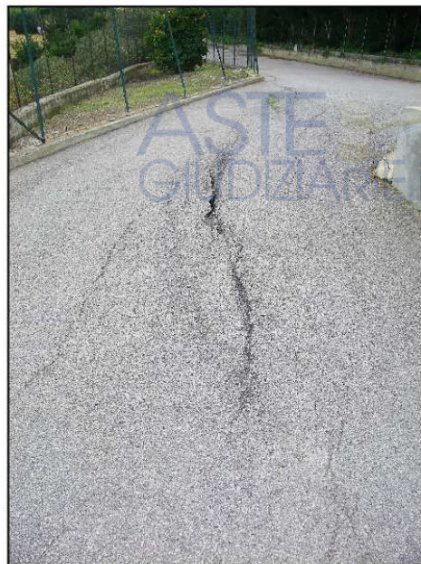
Foto 12. Lesione del manto stradale a monte del lotto
