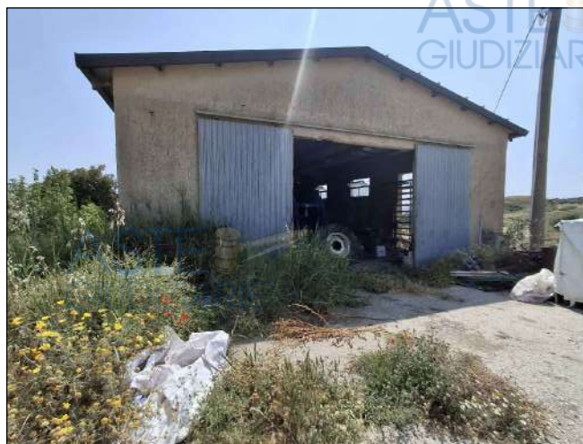
prospetto ovest- fienile
