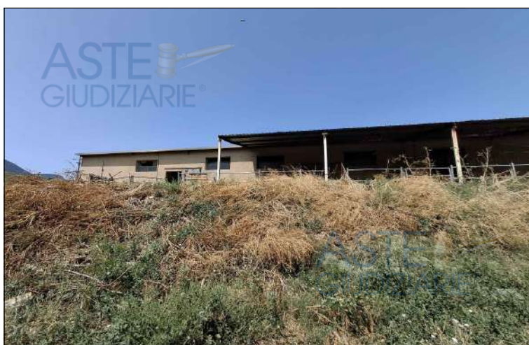
prospetto est- stalla vista dalla strada
