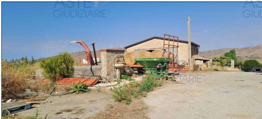
panoramica - abbeveratoio e prospetto ovest- fienile
