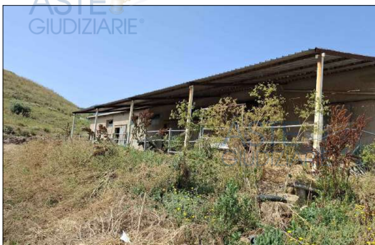
prospetto est- stalla, vista dalla strada
