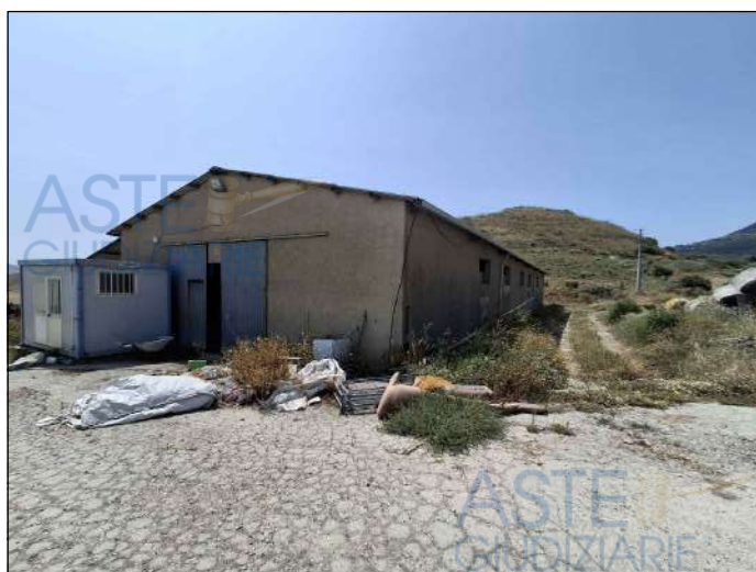
prospetto nord-ovest- stalla, vista dalla corte
