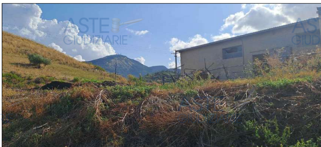
prospetto est- stalla, vista dalla strada
