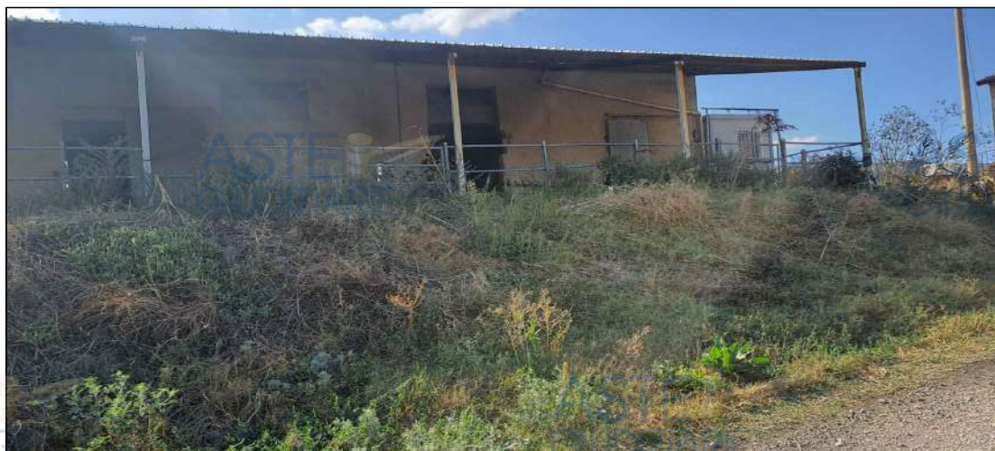
prospetto est- stalla, vista dalla strada
