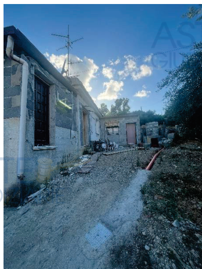
Foto 1-Vista esterna del Corpo A
