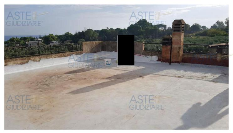
Foto n. 15. Posa in opera della guaina impermeabilizzante (lato Est del terrazzo).
