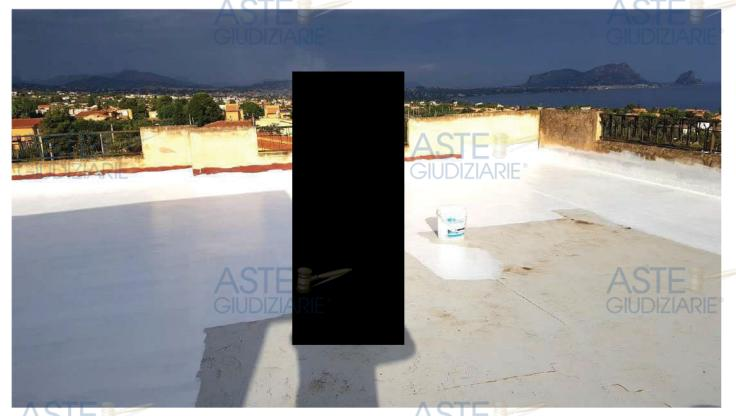
Foto n. 14. Posa in opera della guaina impermeabilizzante (lato Ovest del terrazzo).
