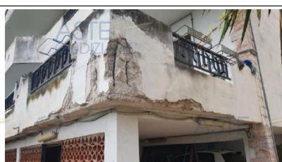
Foto n. 6. Scrostamento del balcone dell'alloggio pignorato.
