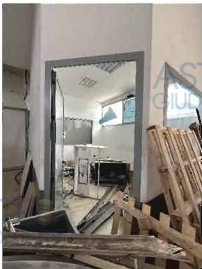
Foto 4- Vista dei vani di servizio
