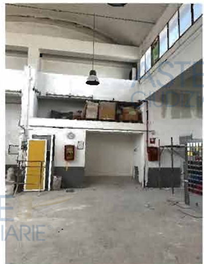
Foto 6- Vista del Vano
