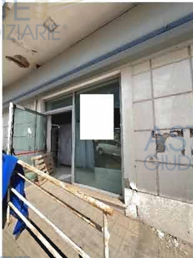
Foto 1 - Accesso al Lotto 1
