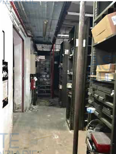
Foto 1- Vano in cui si riscontra la scala in ferro ed una porzione del sottoparco a sostegno dei corpi illuminanti
