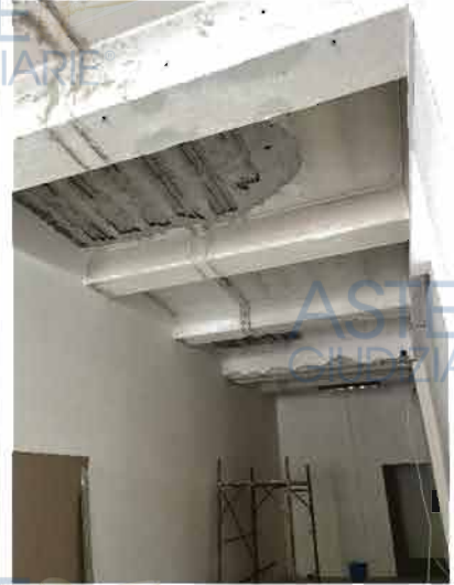
Foto 3- Risanamento intradosso del solaio
