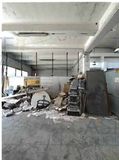
Foto 5- Vista del Vano
