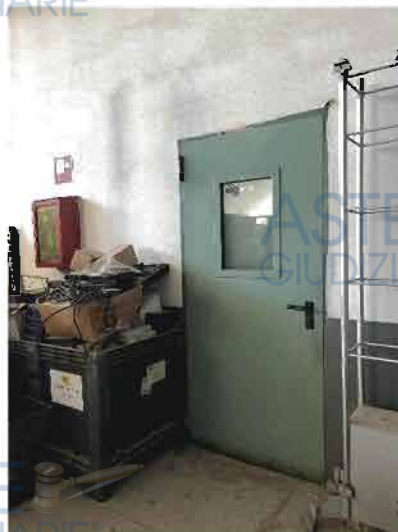
Foto 3- Porta di collegamento con il Corpo 5 (sub.6)
