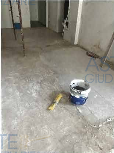
Foto 4- Pavimentazione presente al piano terra
