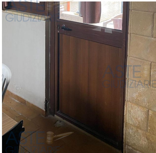
Vista del degrado e corrosione degli imbotti degli infissi in alluminio
