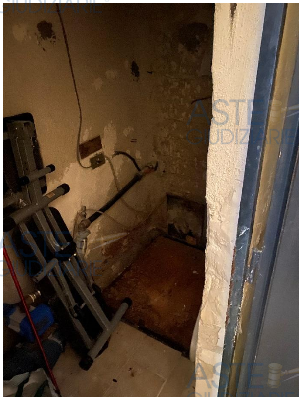
Vista riserva idrica interrata e livello dell'acqua a sfioro del pavimento
