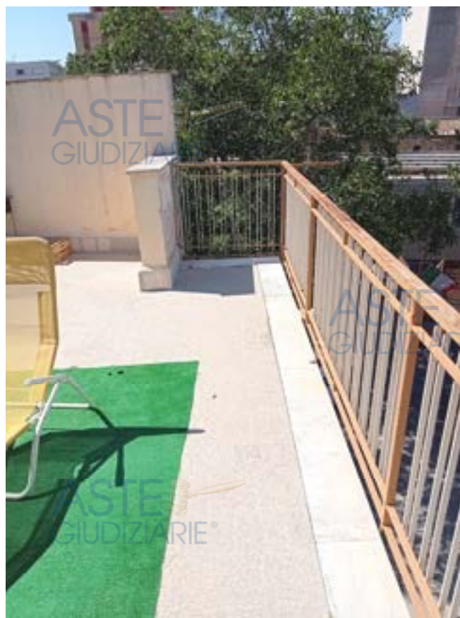
Foto 14: "Terrazza piano terzo con relativo balcone"
