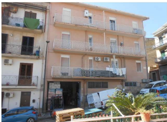
2. Il prospetto col balcone prospiciente Via Gagini
