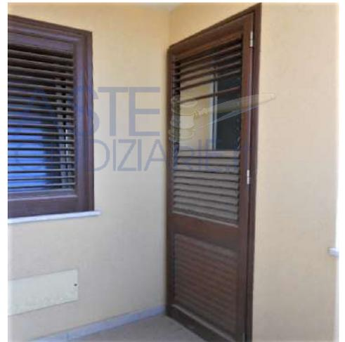
13. PIANO 1. L'INFISSO DELLA LOGGETTA È MANCANTE DI ALCUNE STECCHE INCLINATE (C.D. "GELOSIE") E OCCORRE RIPRISTINARLE.
