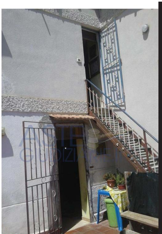
Foto 3: prospetto esterno "ingressi piano terra e primo piani collegati da scala esterna in ferro"
