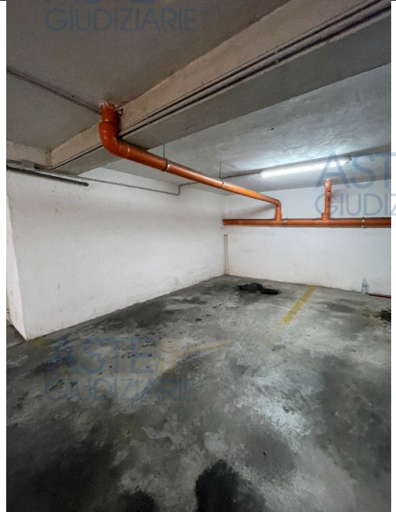
Foto n. 18 Posto auto piano cantinato
