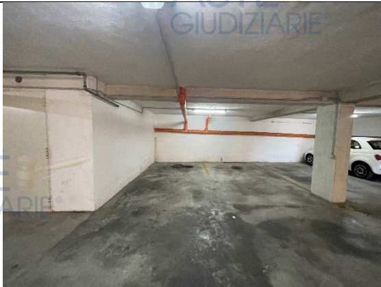
Foto n. 19 Posto auto piano cantinato
