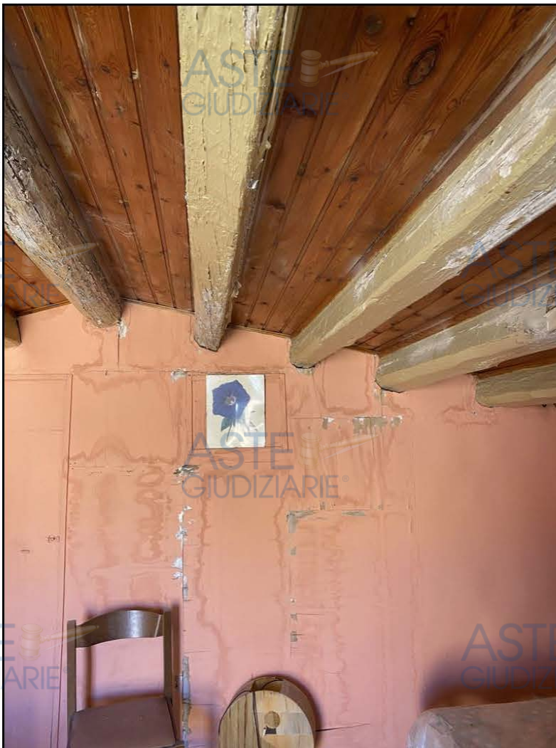
Foto 5 Tetto e travi avvallate proprietà soffitta S [REDACTED]
