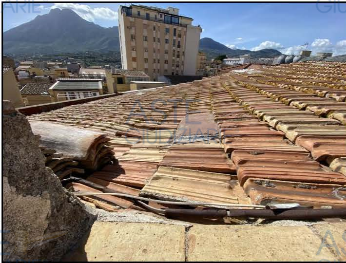
FOTO 4 Tetto e travi avvallate soffitta proprietà [REDACTED]
