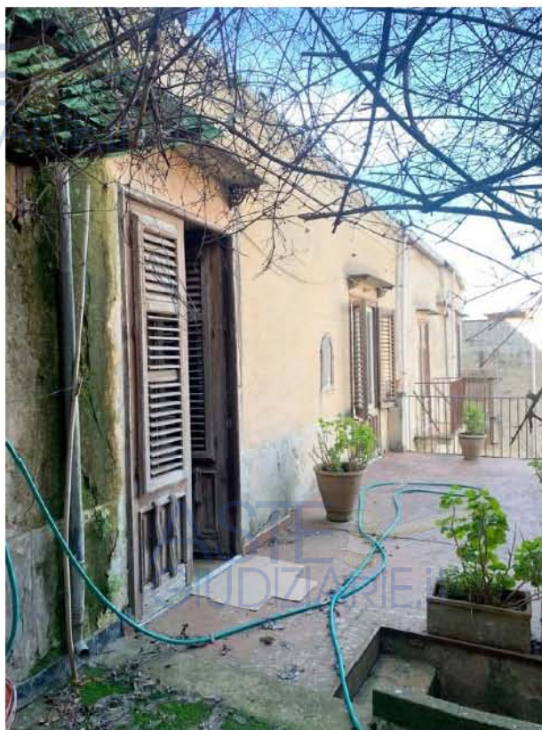
Terrazzo su giardino privato - piano primo-rialzato
