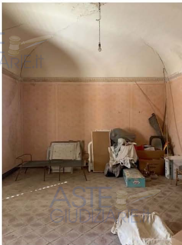
Vano al piano secondo
