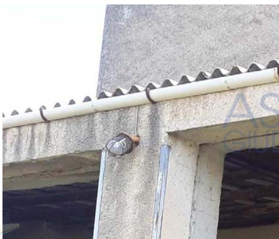
Foto 14 – Dettaglio copertura in amianto
