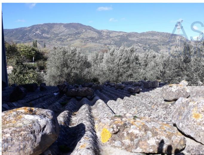
*Foto 46 – Dettaglio copertura in cemento - amianto*
