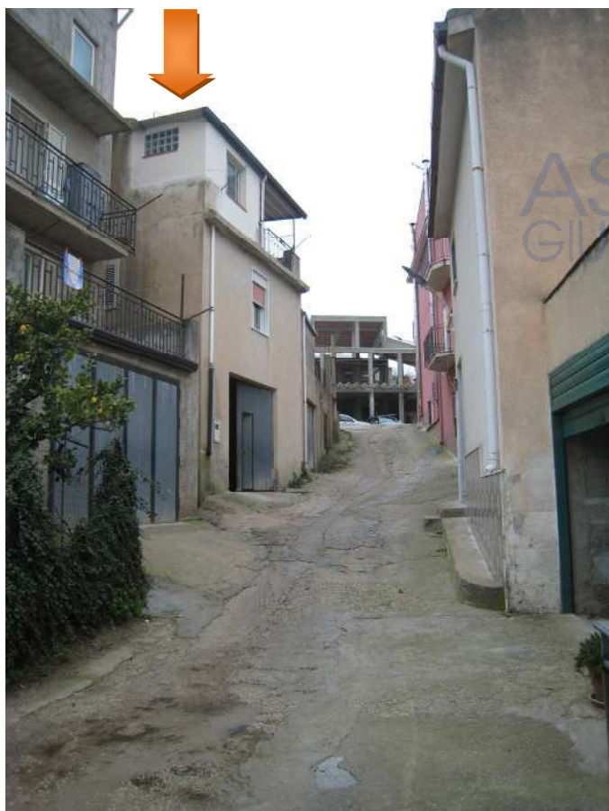
Foto n. 2. Il fabbricato realizzato sulla p.lla 325.
