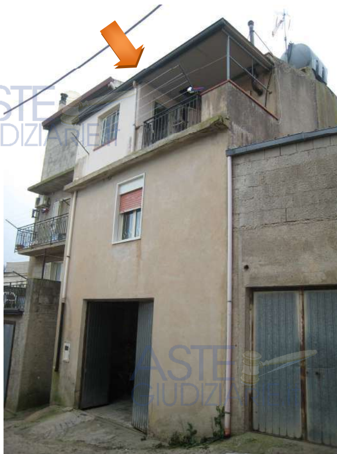
Foto n. 3. Dettaglio del prospetto principale.
