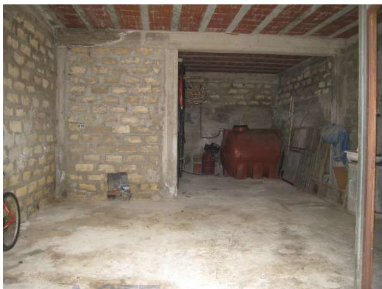
Foto n. 5. Il magazzino al P.T..
