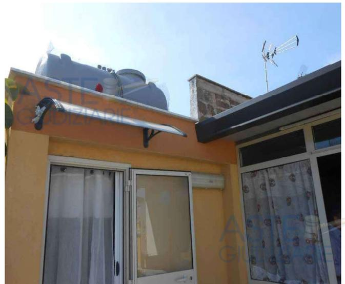
34. Piano 3°, Terrazza. A sinistra il torrino scala di arrivo della scala a chiocciola con solaio piano con serbatoio acqua potabile da 1000 lt, a destra la veranda.
