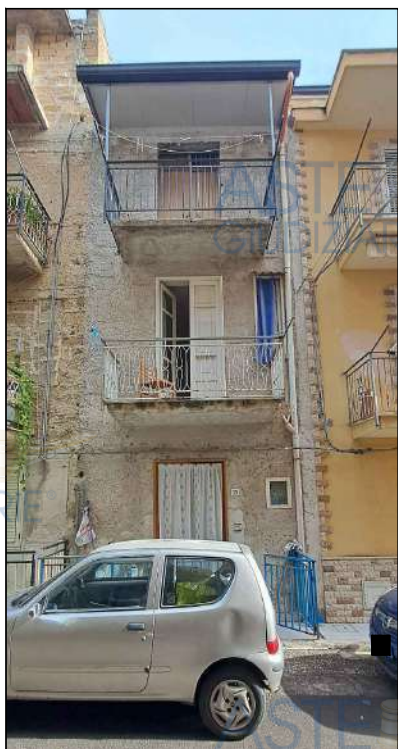
prospetto su via Giacomo Matteotti
