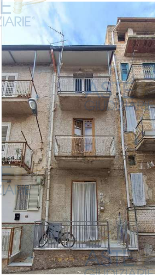
Prospetto su via Giacomo Matteotti
