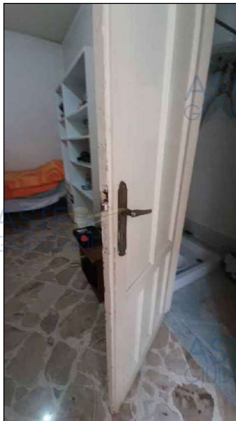
bagno piano primo
