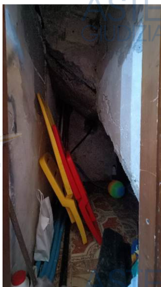
Umidità di risalita disimpegno sottoscala Ammaloramento soletta scala
