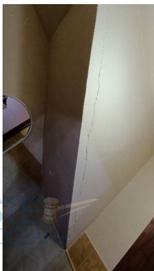
Lesione soletta scala Lesione struttura verticale
