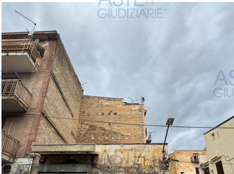
Vista muro laterale
