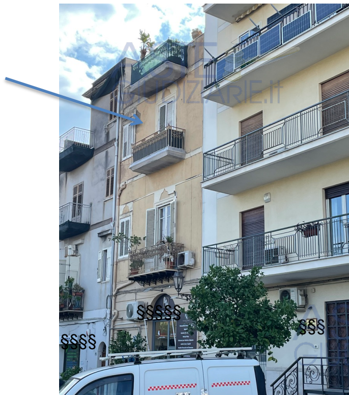
Immagine 4 – prospetto dell'edificio
