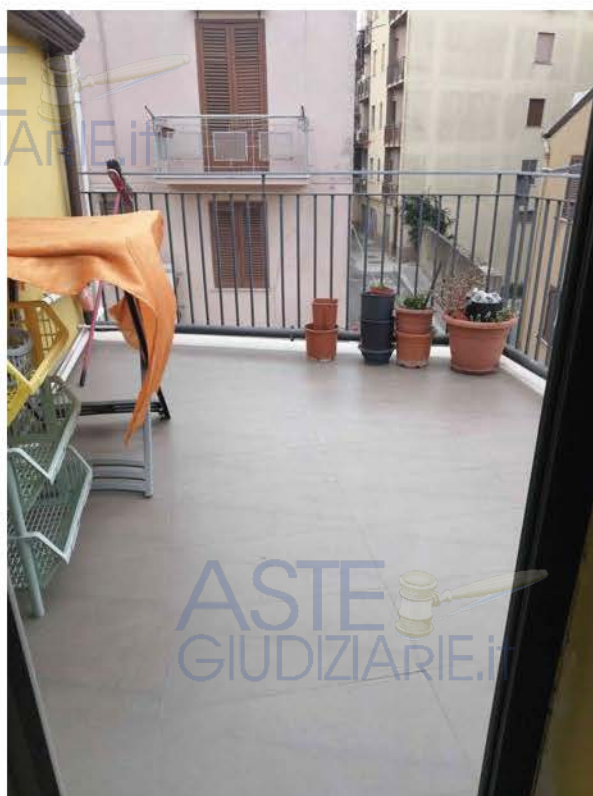
Foto n. 13 – terrazzo piano secondo
