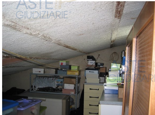
ZONA SOTTOTETTO LATO SIX SALEND
