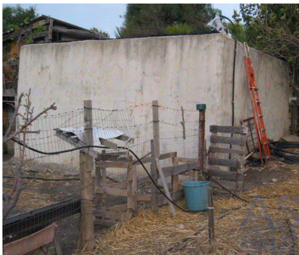
Vasca oggetto di demolizione
