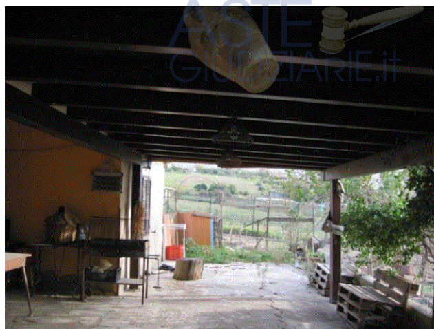
Vista verso ingresso immobile e copertura precaria
