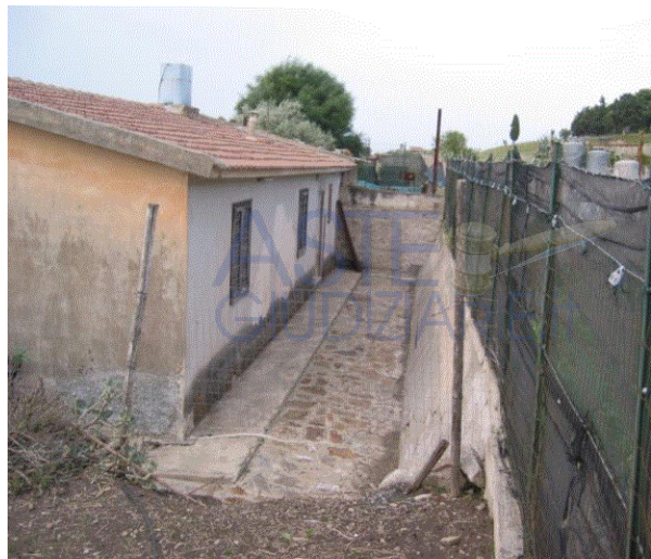
Veduta scarpata lato Est
