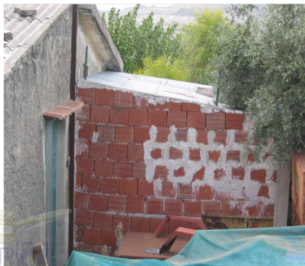
Vista da Est "deposito materiali" oggetto demolizione
