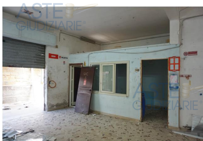
11 | vista dei servizi (ripostiglio e bagno)
