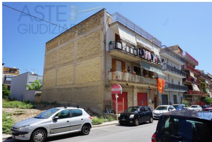
2 | Foto da via E. Maiorana lato Ovest
