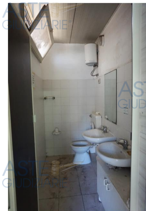
14 | vista del bagno
