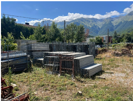
FOTO 7: IMPALCATURE E PONTEGGI
