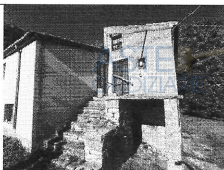
Vista della porzione di fabbricato
