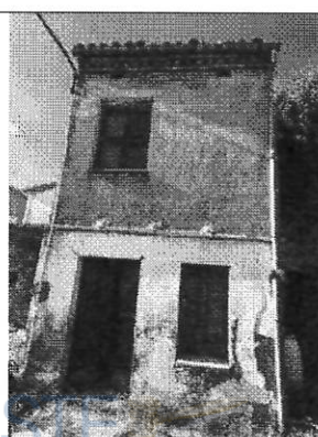
Vista della porzione di fabbricato
