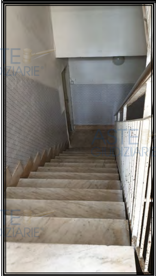
FOTO 16 - Accesso al piano seminterrato
