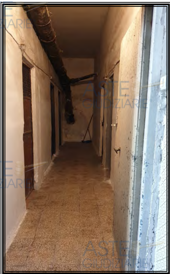
FOTO 17 - Disimpegno piano seminterrato
