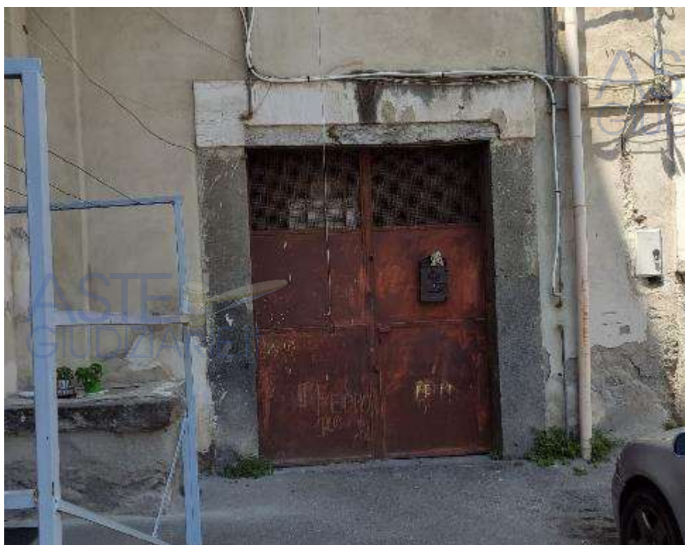
VISTA ESTERNA DEL LOCALE DEPOSITO
