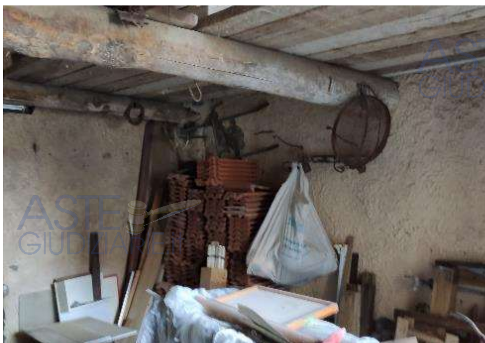
VISTA INTERNA DEL LOCALE DEPOSITO
