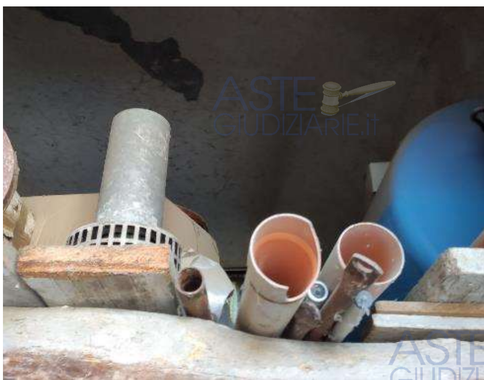
VISTA INTERNA DEL LOCALE DEPOSITO
