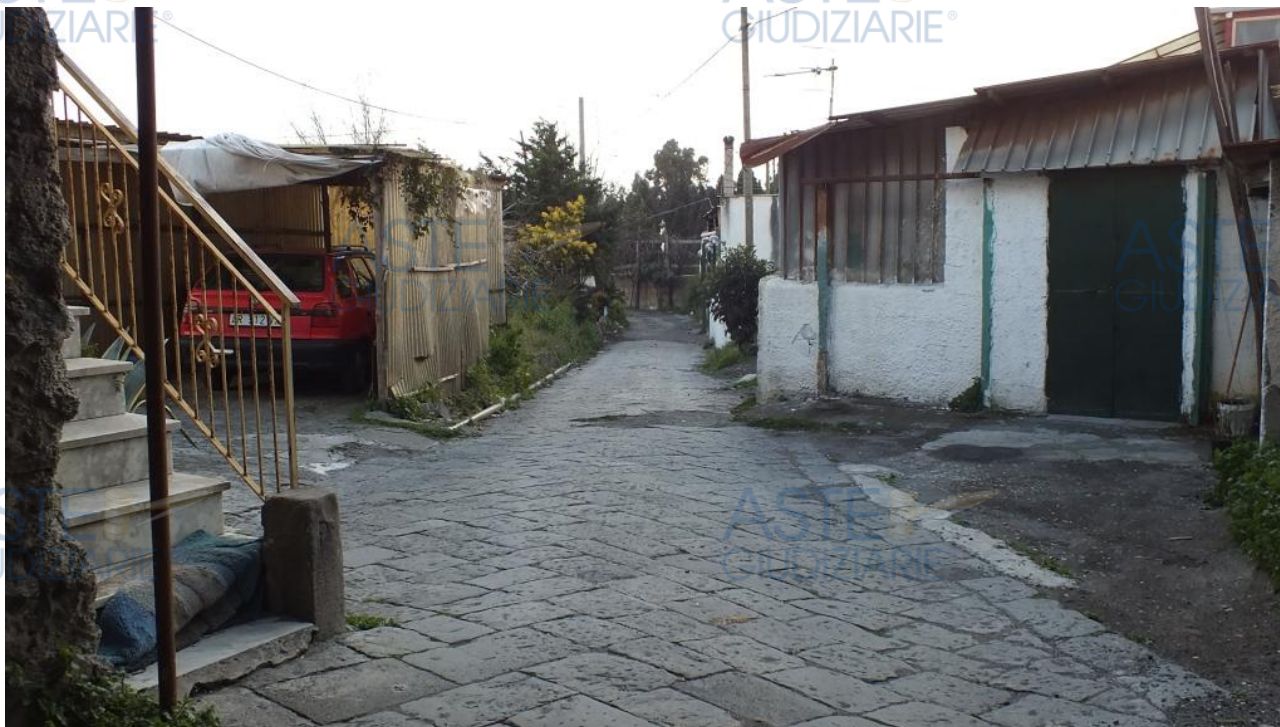
Foto 7 – Vista della tettoia annessa al negozio con accesso dalla strada interna al fondo
