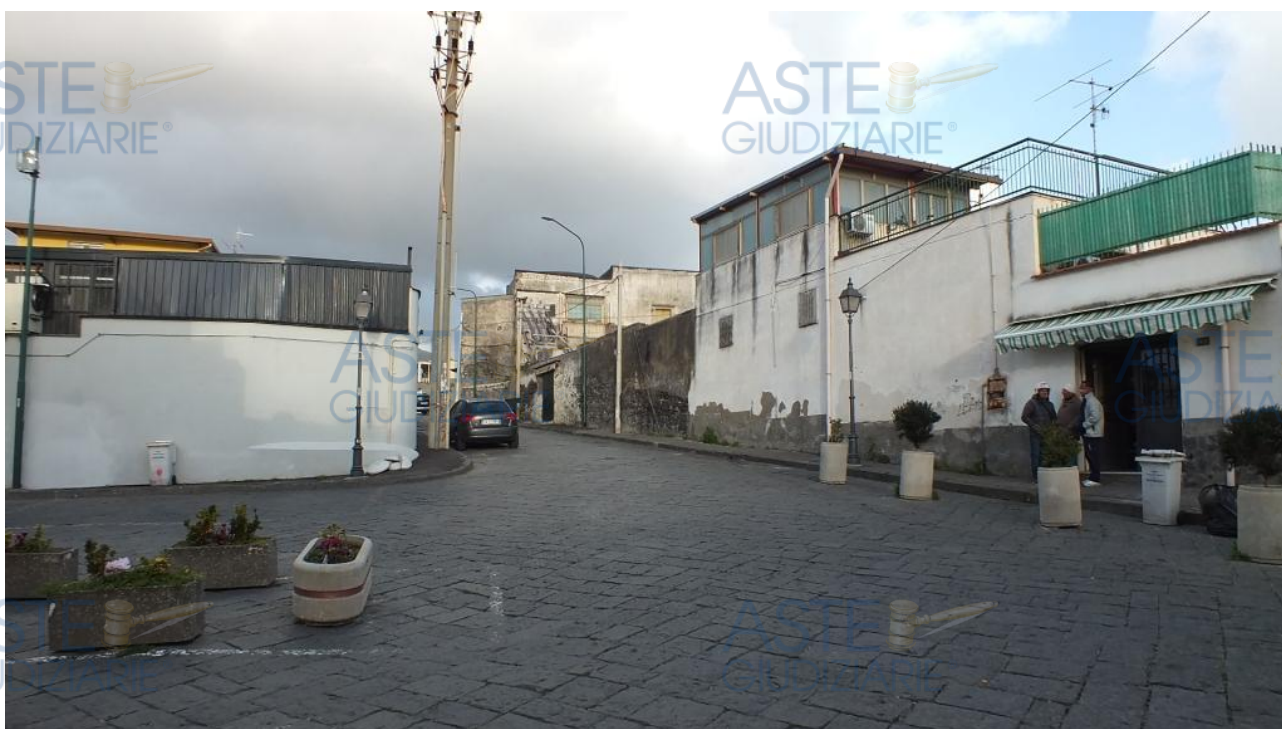
Foto 6 – Vista di insieme dalla via del Cimitero del fabbricato adibito ad abitazione e del negozio
