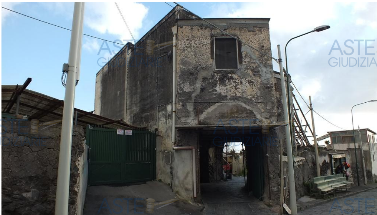
Foto 1 – Fabbricato rurale che funge di accesso al compendio immobiliare dalla via del Cimitero
