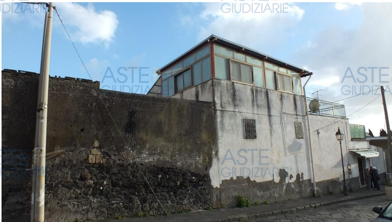
Foto 5 – Fabbricato adibito ad abitazione su due livelli
