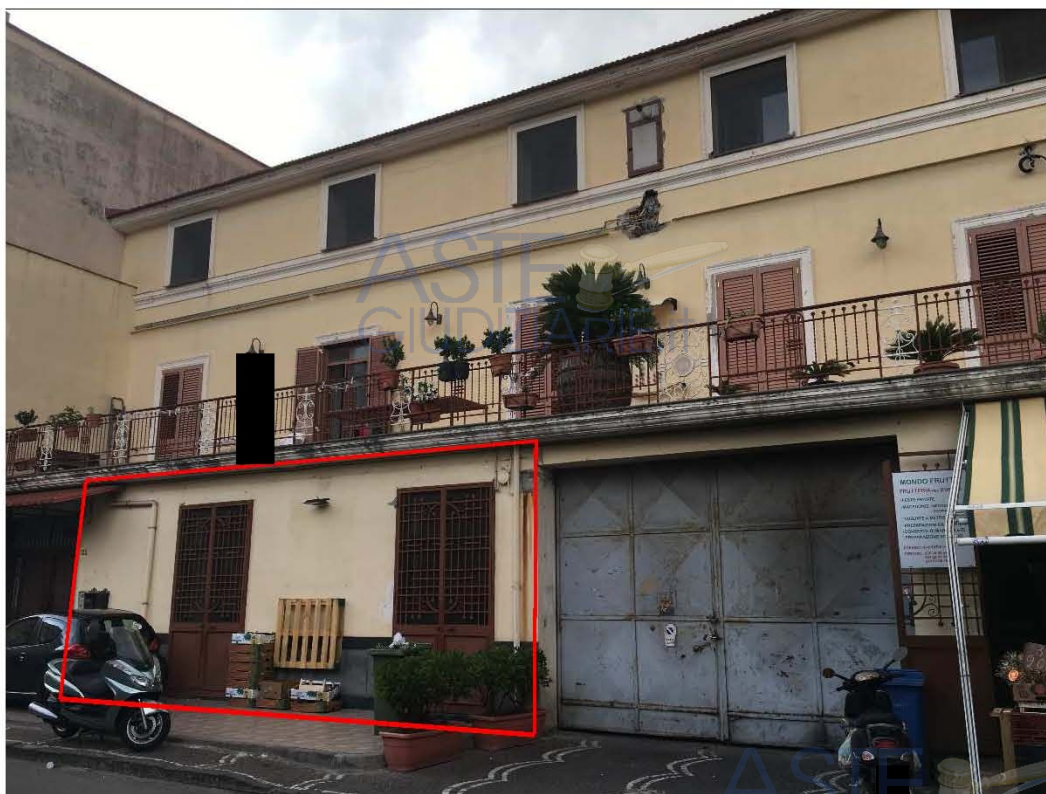
Foto 1_vista dall'ingresso di OMISSIS
