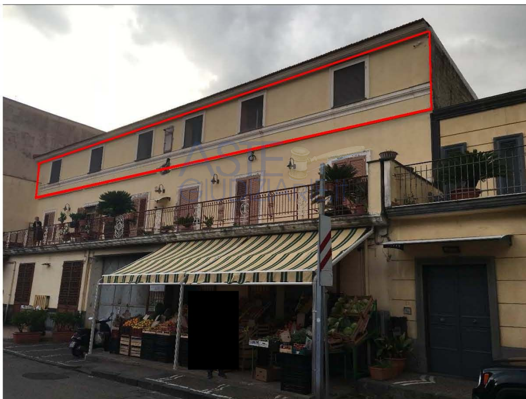
Foto 1_vista dall'ingresso di OMISSIS
