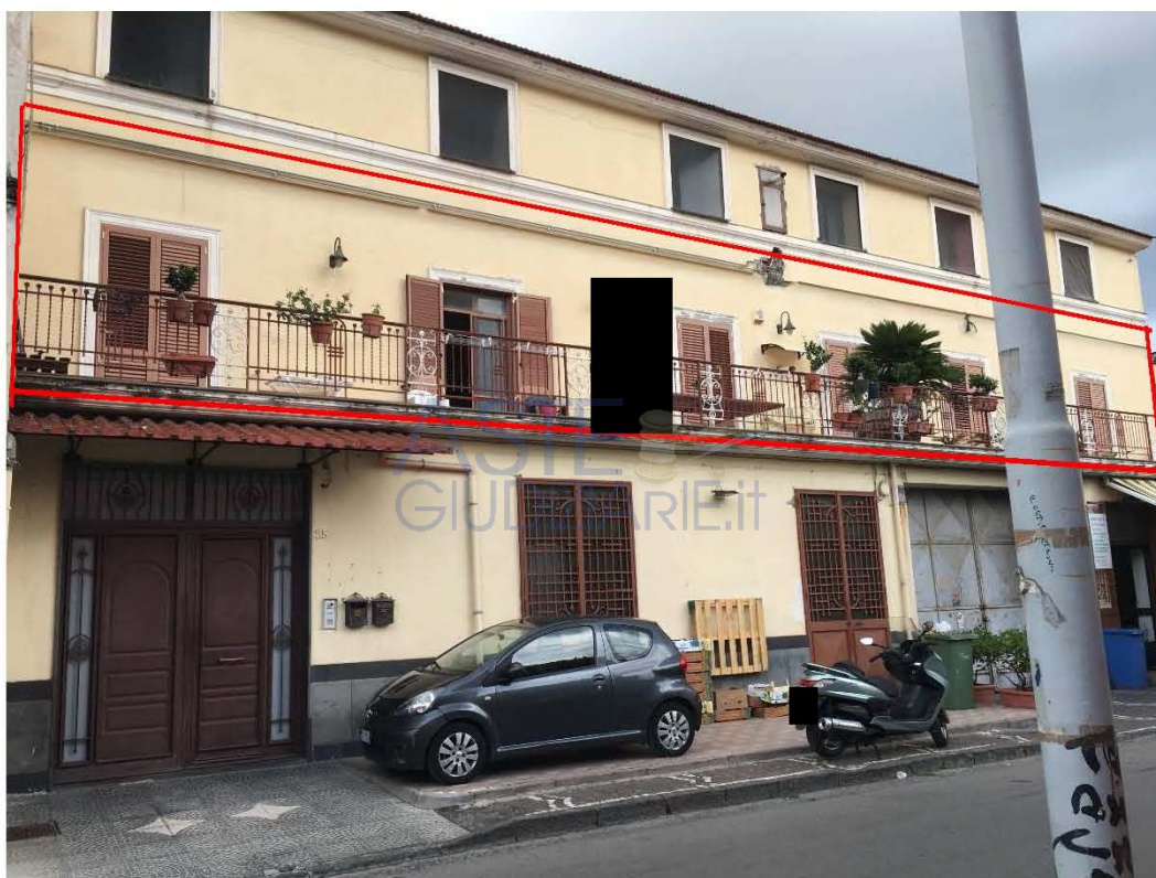
Foto 1_vista dall'ingresso di OMISSIS
