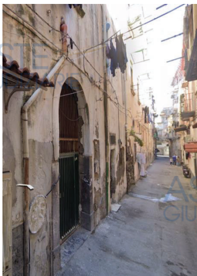
Figura 4- vista parziale della facciata del fabbricato- CONSERVAZIONE.
