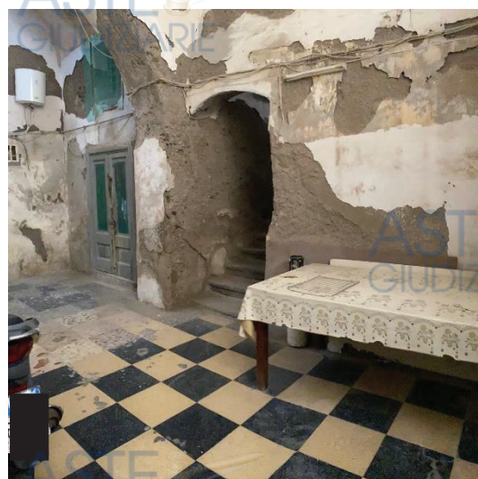
Figura 6- rampa di accesso
