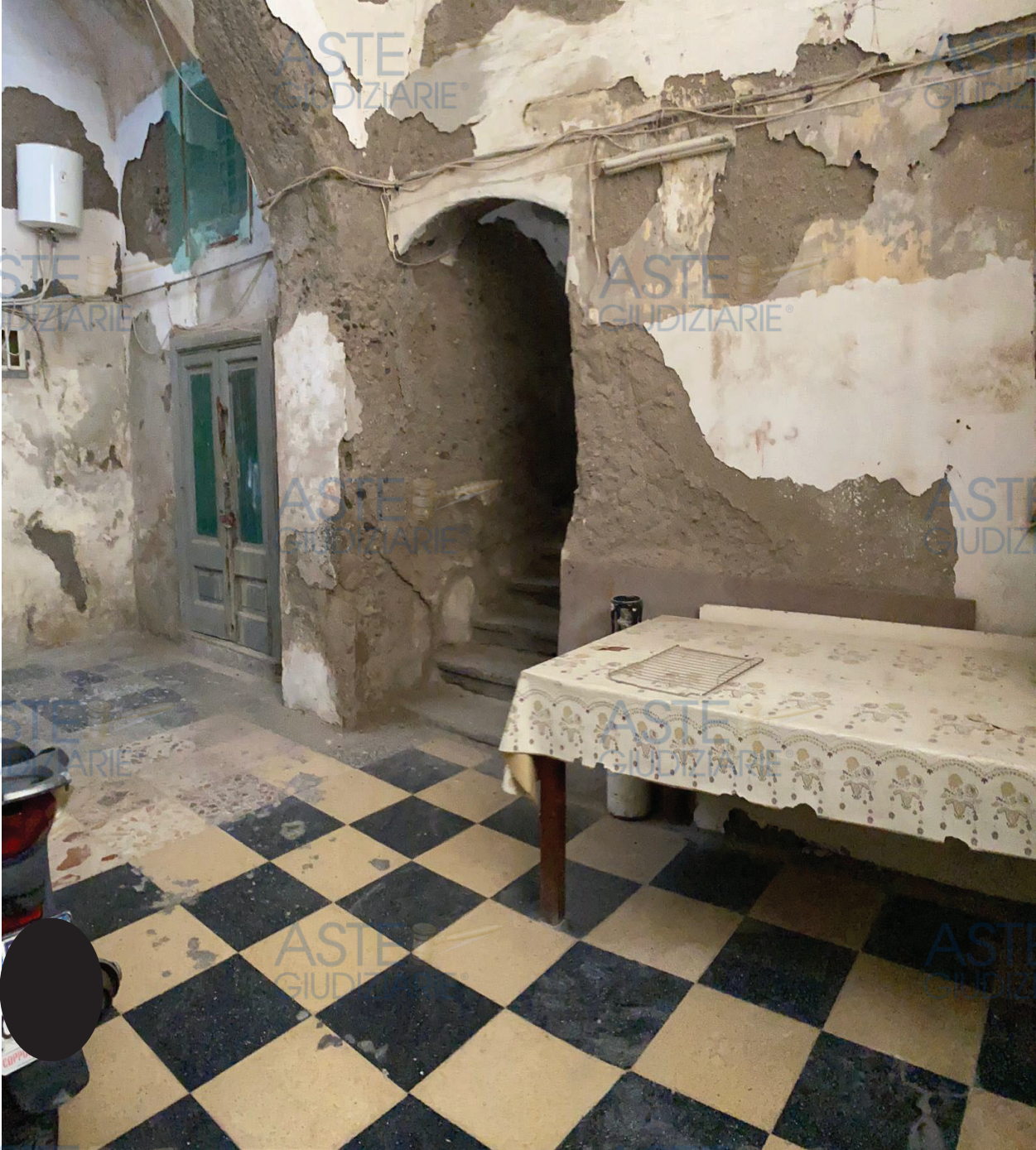
Figura 50- corte interna- accesso al vano scala
