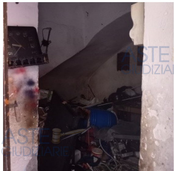
Figura 17 deposito al piano terra
