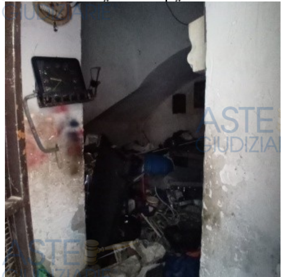
Figura 15 deposito al piano terra
