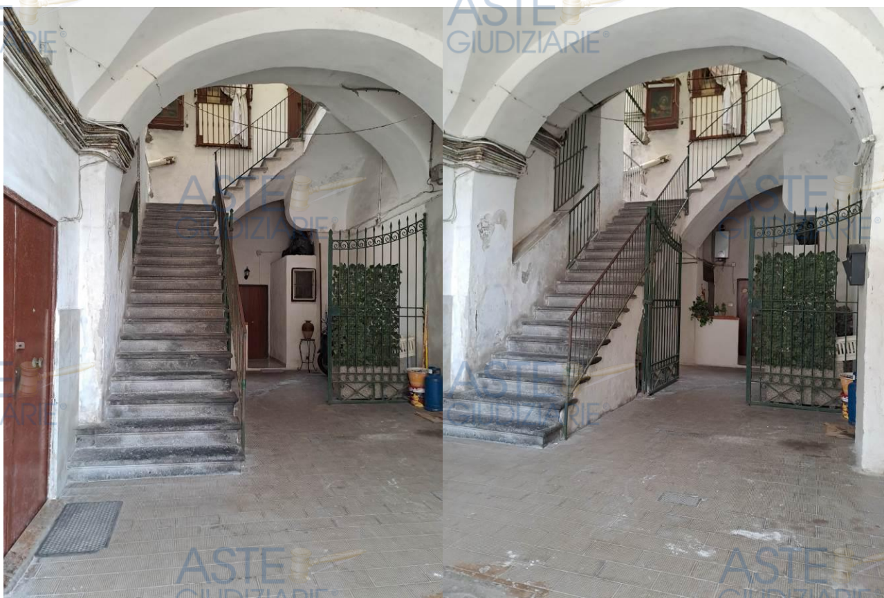
Foto n° 3 Zona ingresso Fabbricato - Androne.
