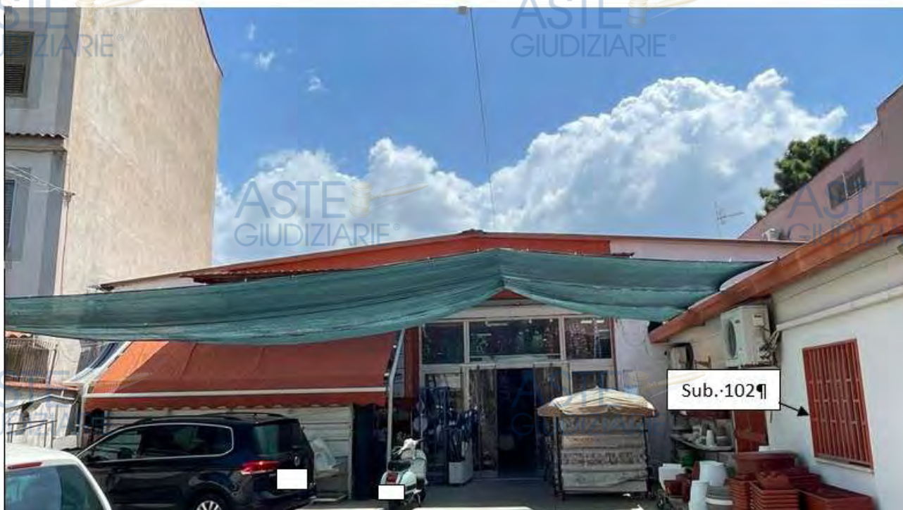
Ingresso u. i. sub. 1
