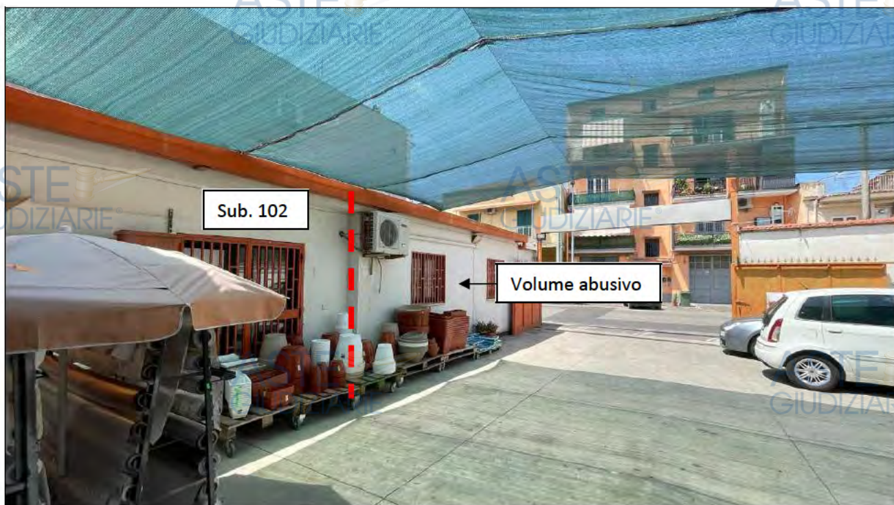
Area esterna in comune con u. i. sub. 102
