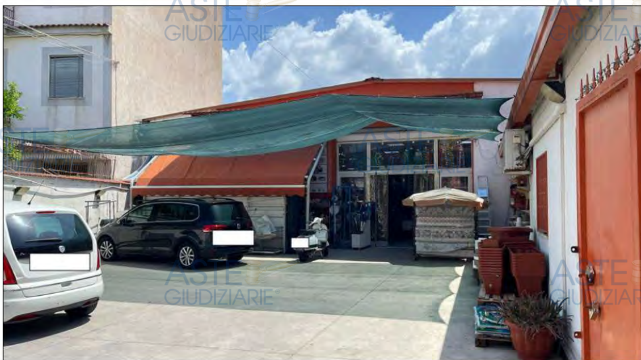
Area esterna in comune con u. i. sub. 102
