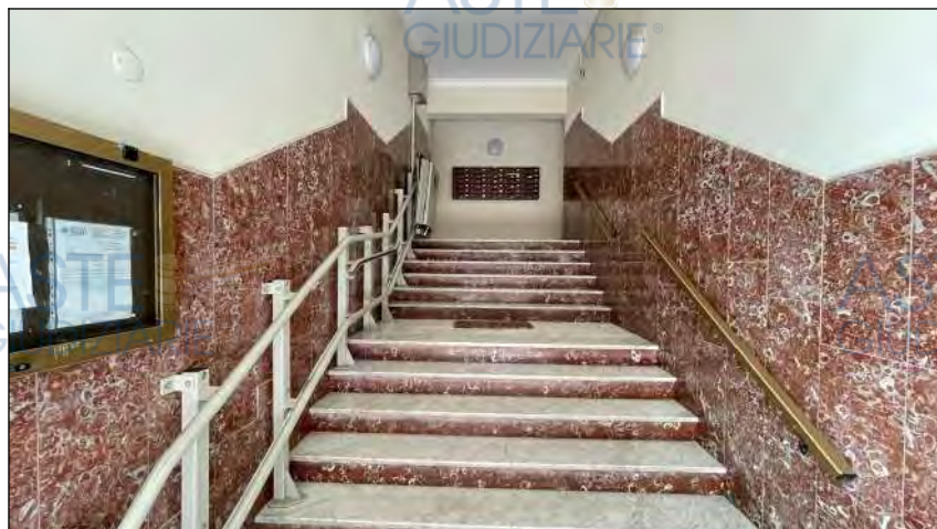
Rampa di ingresso scala B
