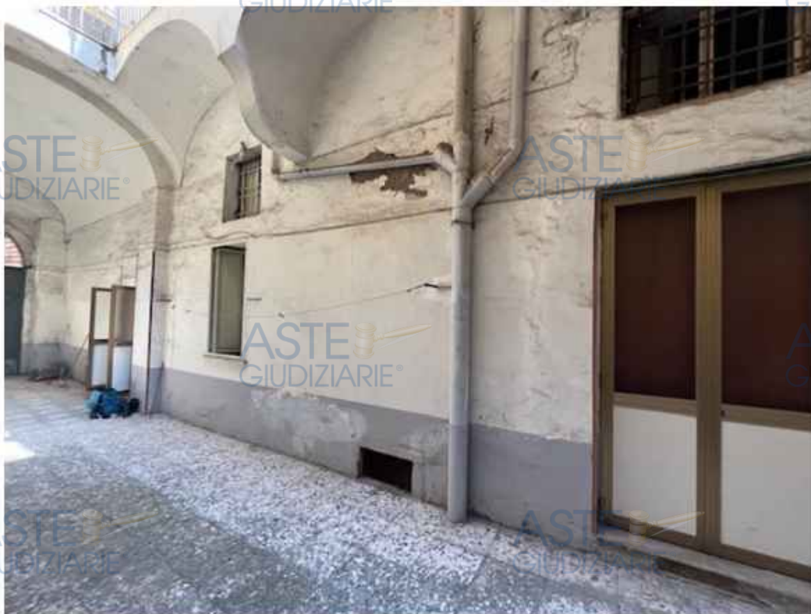
Foto 5, Foto 6 Prospetti interni su androne interno condominiale
