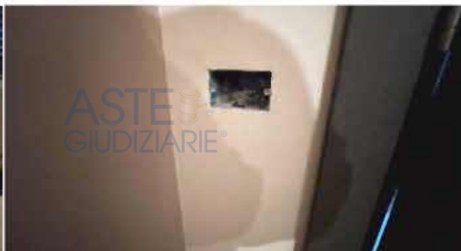
Cassette a muro sprovviste di frutti
