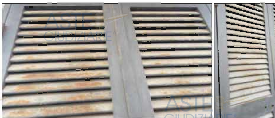
Particolari di persiana napoletana: corrosione superficiale
