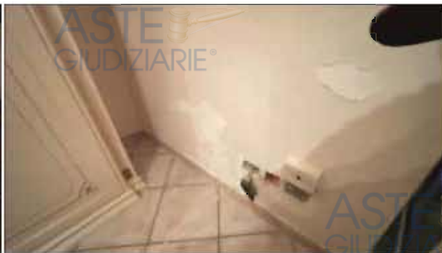
Sfogliamenti di pittura dovuti all'umidità di risalita
