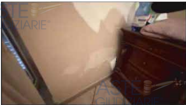
Sfogliamenti di pittura dovuti all'umidità di risalita
