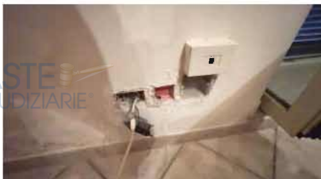
Cassette a muro sprovviste di frutti
