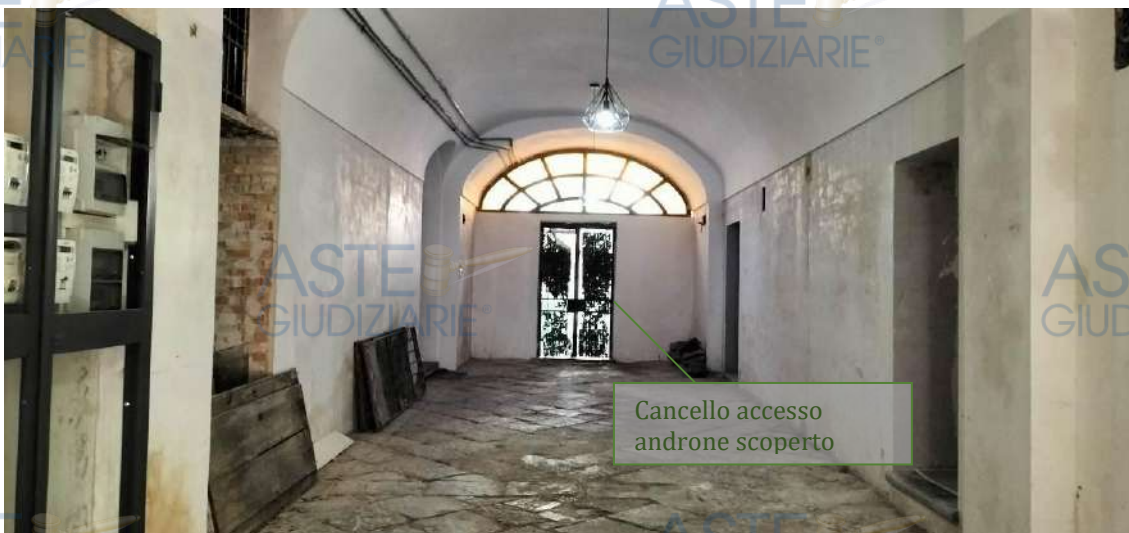
Androne comune coperto_ cancello ingresso androne scoperto
