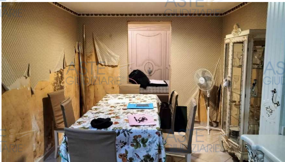
Particolare parete zona soppalcata
