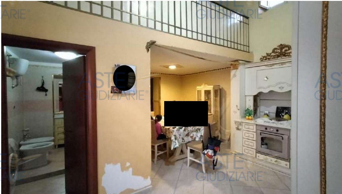
Ingresso/ cucina: zona soppalcata
