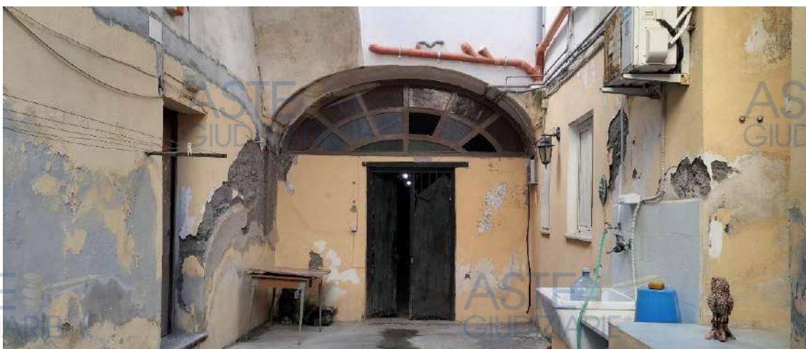
Androne comune scoperto_ cancello ingresso lato interno
