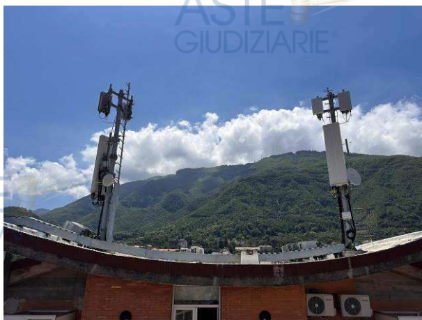
Prospetto nord paline di ancoraggio antenne e parabole ponti radio sulla copertura
