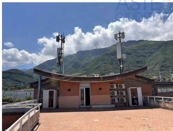
Prospetto nord paline di ancoraggio antenne e parabole ponti radio sulla copertura
