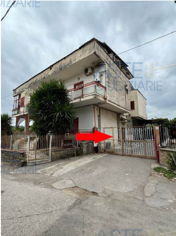
Individuazione ingresso immobile in cui è allocato il cespite pignorato
