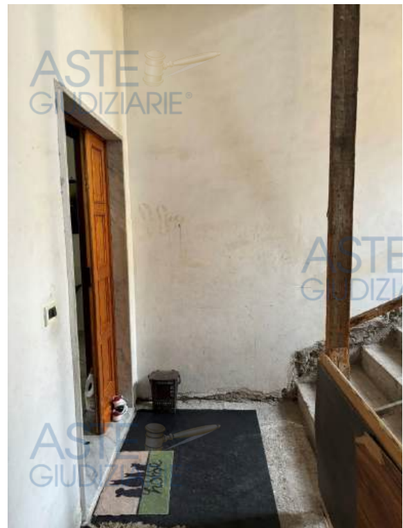
Vista vano di accesso al bene pignorato
