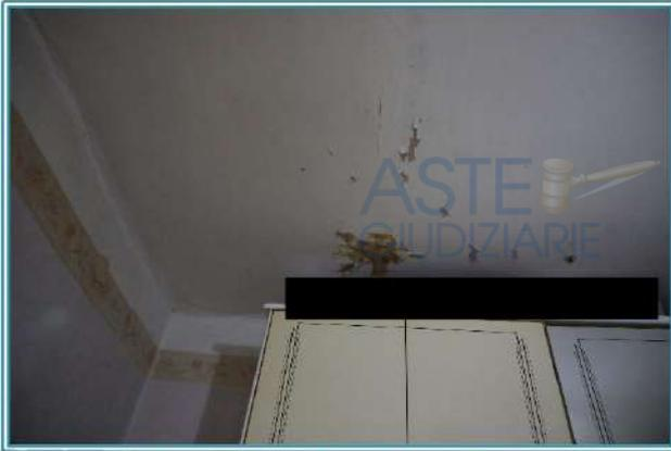
Figura 32 Segni di ammaloramento sul controsoffitto della camera1
