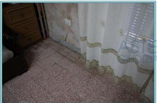
Figura 35 Segni di ammaloramento sulla parete esterna e un leggero abbassamento del pavimento nel Salone
