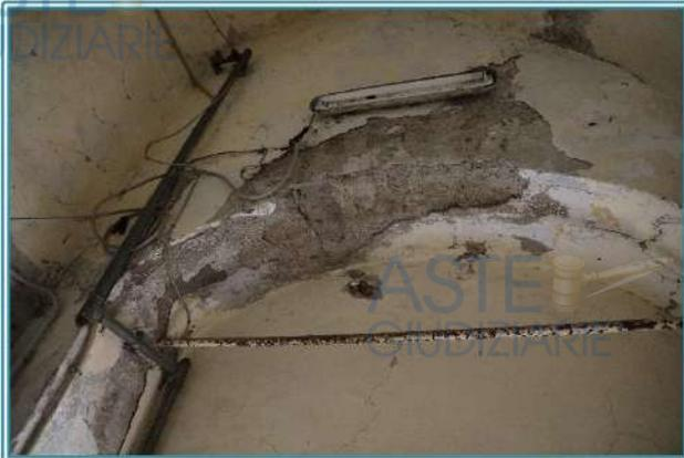
Figura 10 Distacco di calcinacci all'interno dell'androne
