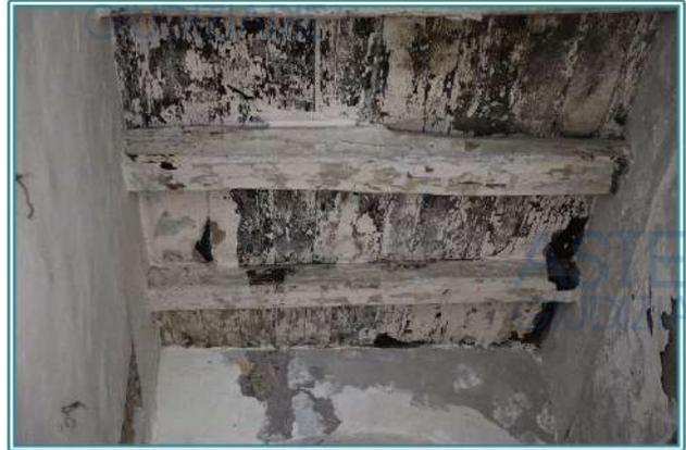
Figura 9 Segni di ammaloramento sul soffitto e sulle pareti dell'ingresso al fabbricato
