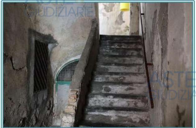
Figura 11 Scala di accesso ai piani con evidenti segni di ammaloramento
