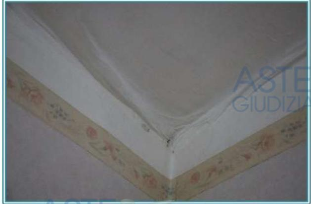
Figura 31 Particolare del controsoffitto in tela nella camera1
