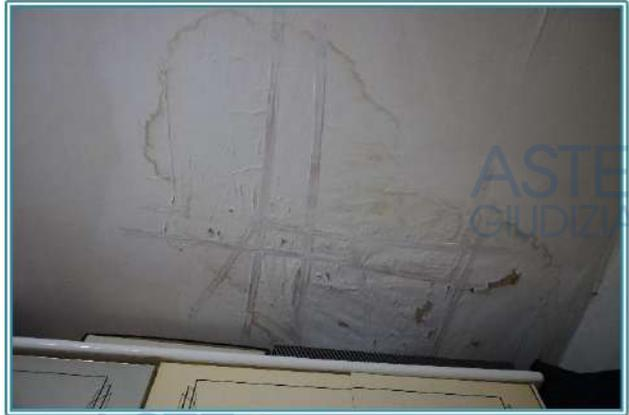
Figura 33 Evidenti segni di ammaloramento sul controsoffitto della camera1
