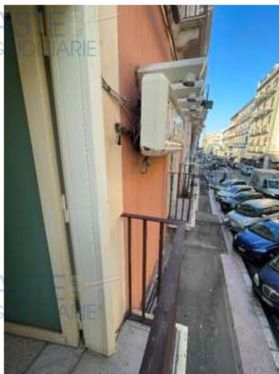
Foto 06 – Balconcini su via Anfiteatro
