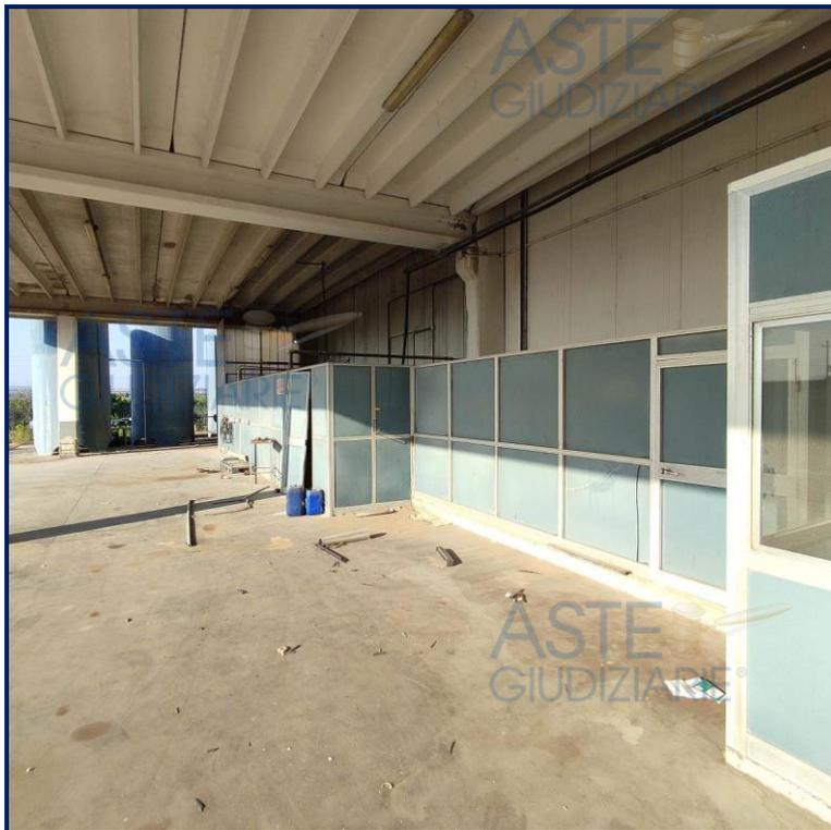
In testata lato Ovest è presente, al primo piano, l'area uffici di dimensioni in pianta pari a mt 8.41x64.52 = mq **542.61** ed altezza utile pari a mt 3.00 a livello del controsoffitto, realizzata con pilastri in c.a.p. e copertura in tegoloni in c.a.p..
