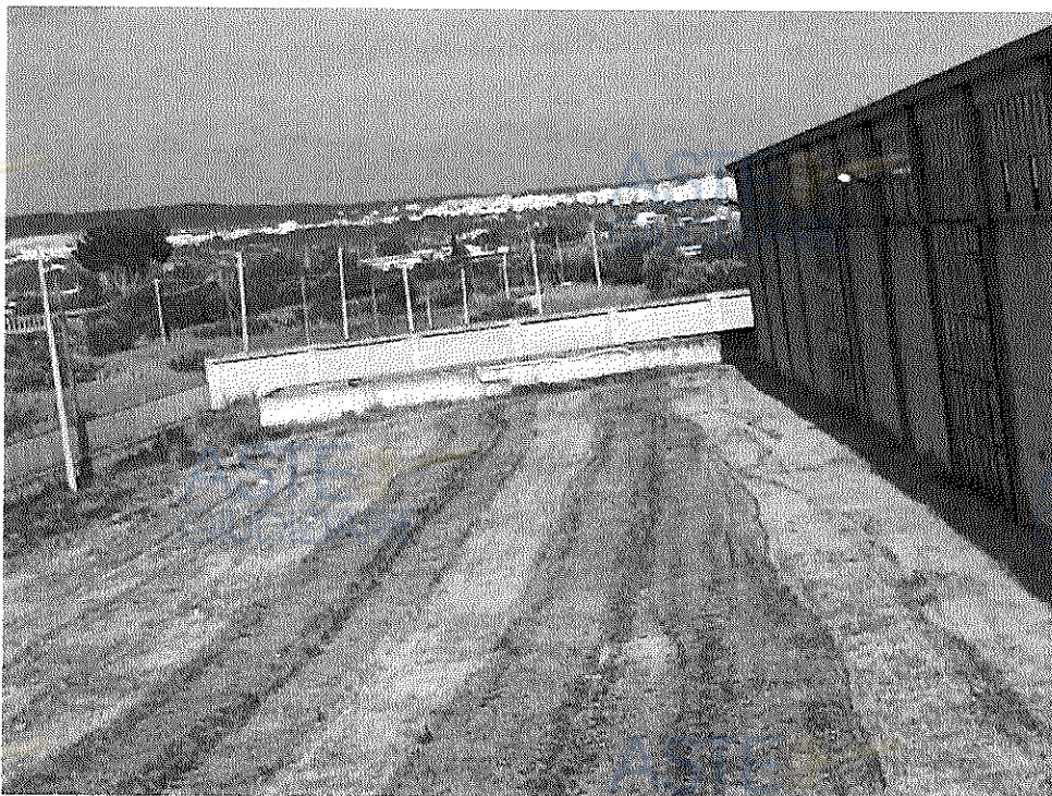
Foto 1: lato Nord - Est
