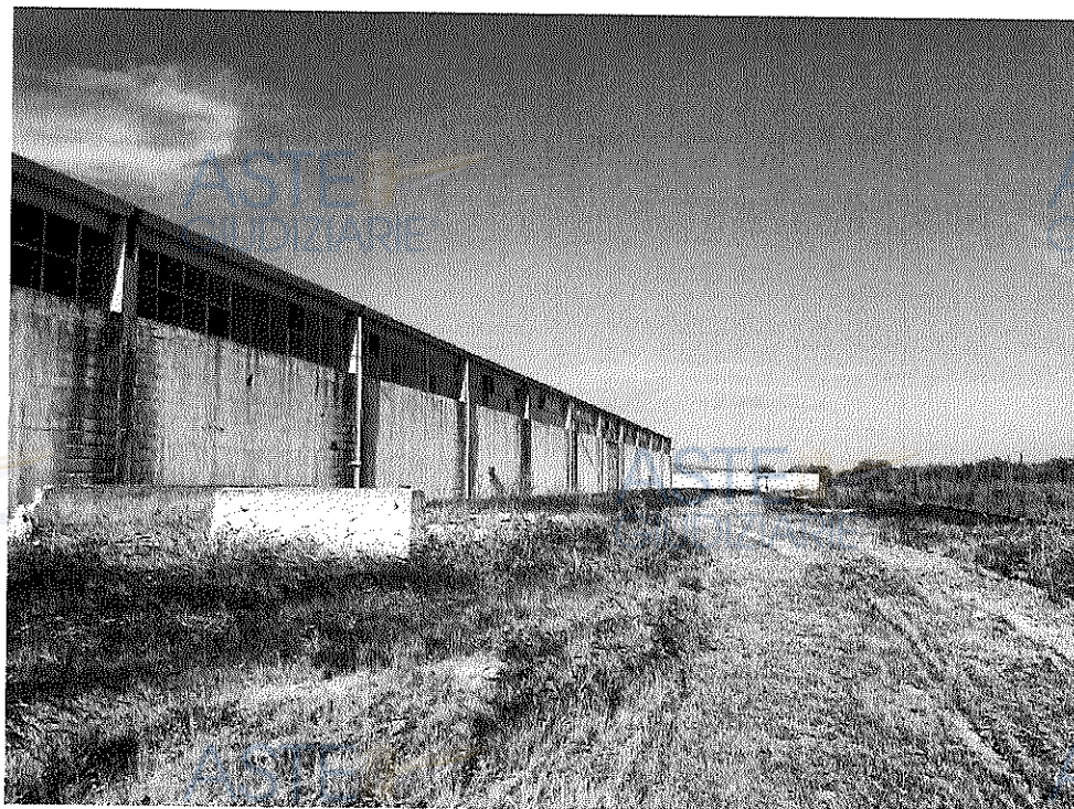
Figura 2: Lato Sud - Est
