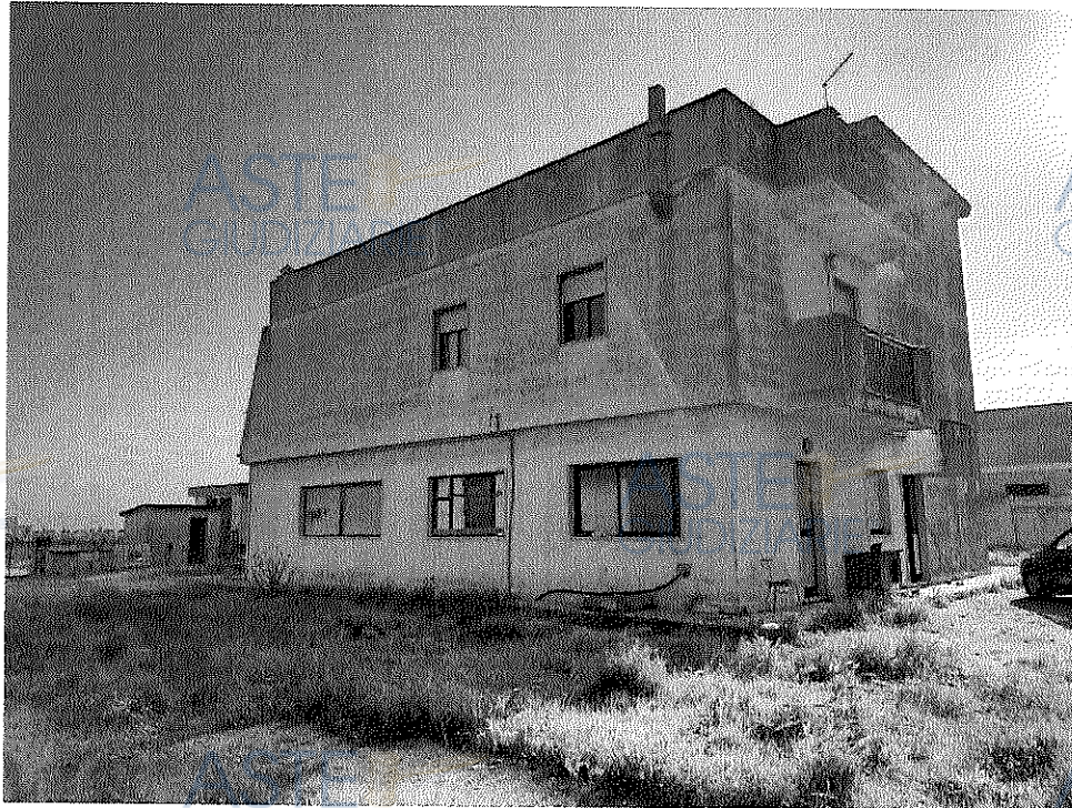
Foto 5: Palazzina uffici e casa del custode
