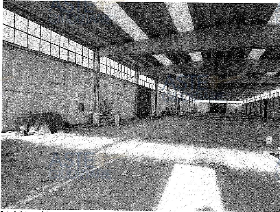
Foto 4 : interno del capannone
