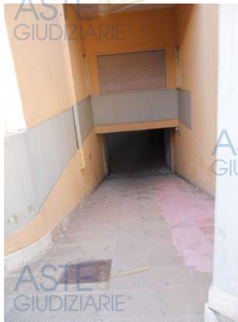
FOTO – rampa di accesso al piano
