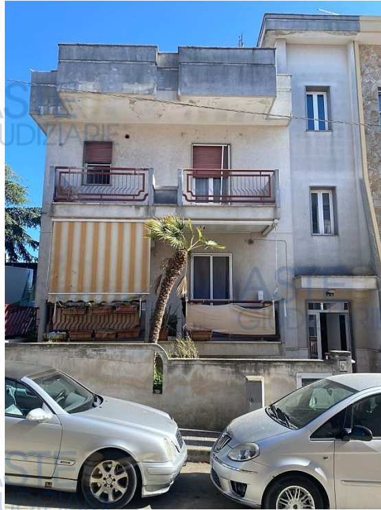
Foto 1 – Facciata Esterna su via [REDACTED]
