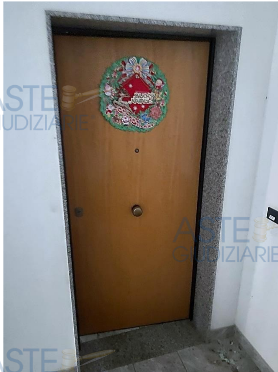
Foto 3 – Porta di Ingresso all’Appartamento
