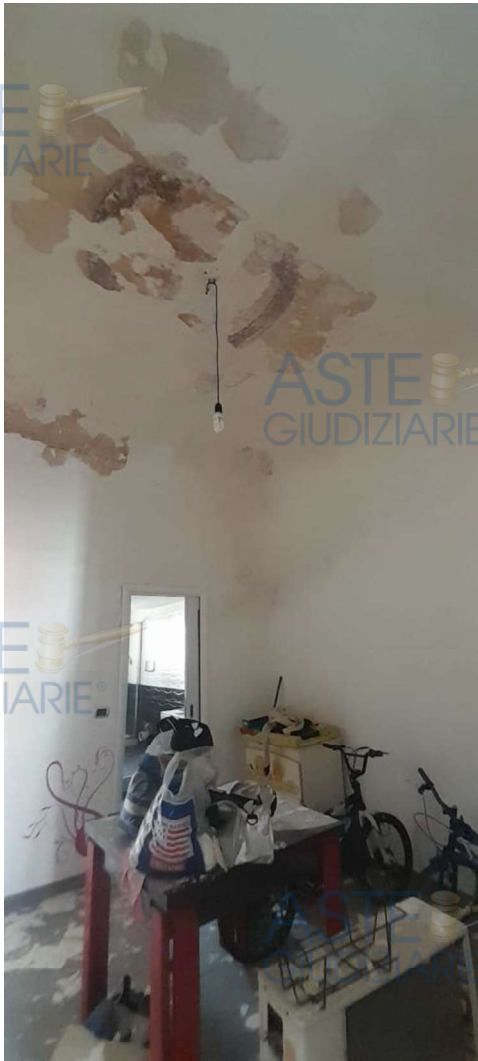
FOTO N.1 Vista dalla porta d'ingresso
