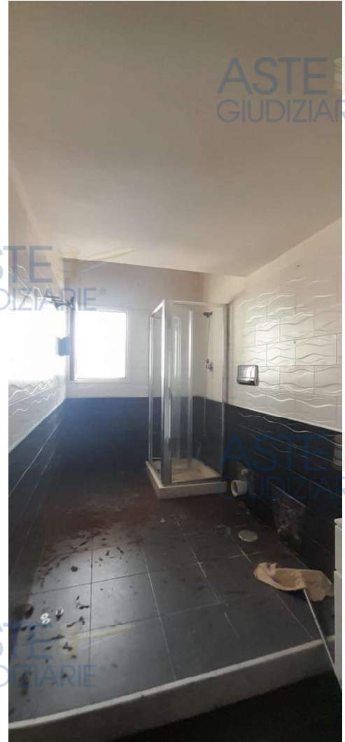
FOTO N. 9 Vista del bagno
