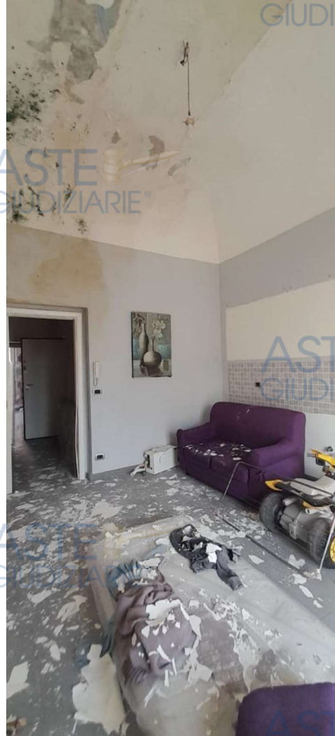
FOTO N. 4 Vista dalla cucina verso la zona d'ingresso
