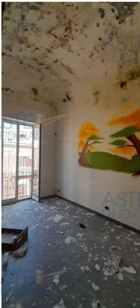
FOTO N. 6 Vista della cameretta dall'ingresso
