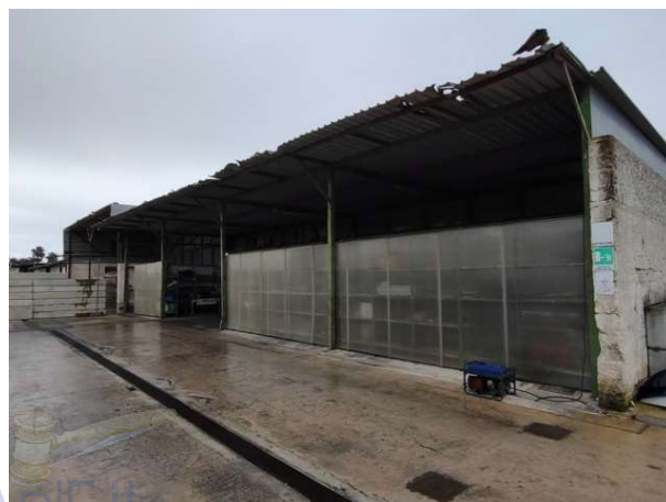
Foto 16: Edificio 2 (Vista verso Sud Ovest)
