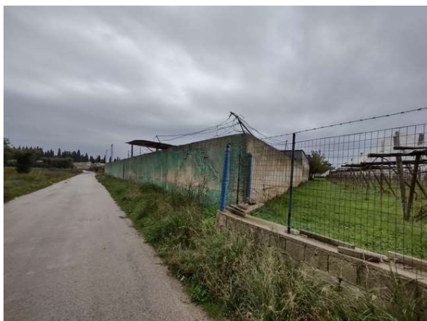
Foto 5: Muro di cinta lati Nord e Nord-Ovest
