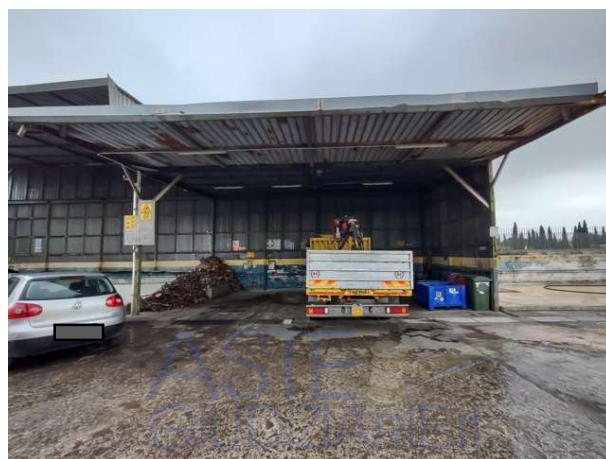
Foto 12: Particolare Edificio 1 (Vista verso Est)
