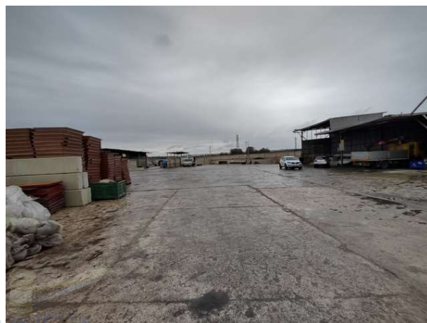
Foto 10: Vista del piazzale interno verso Nord
