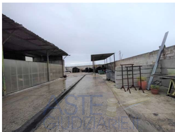
Foto 30: Edifici 2 e 6 (vista verso Nord)
