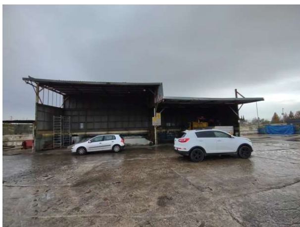
Foto 11: Edificio 1 (Vista verso Est)
