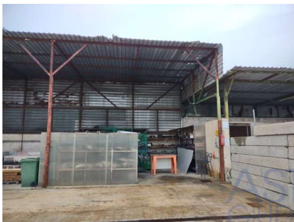
Foto 21: Particolare Edificio 3 (Vista verso Ovest)
