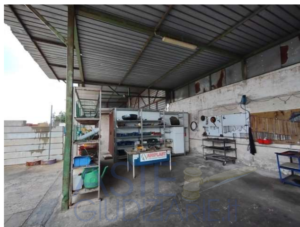
Foto 18: Interno Edificio 2 (Vista verso Sud)
