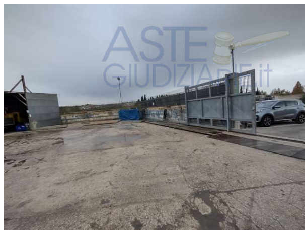
Foto 8: Particolare piazzale (Vista verso Est)
