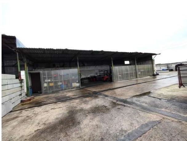
Foto 17: Edificio 2 (Vista verso Ovest)
