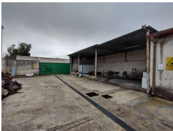
Foto 27: Edificio 5 e cancello secondario verso Sud
