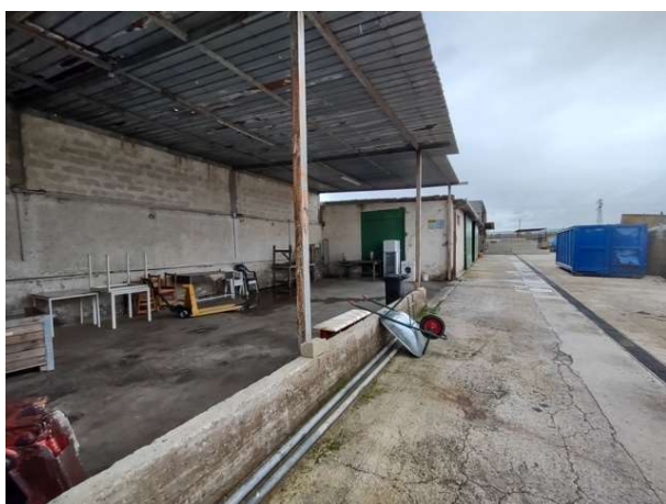
Foto 29: Interno Edificio 5 (vista verso Nord)
