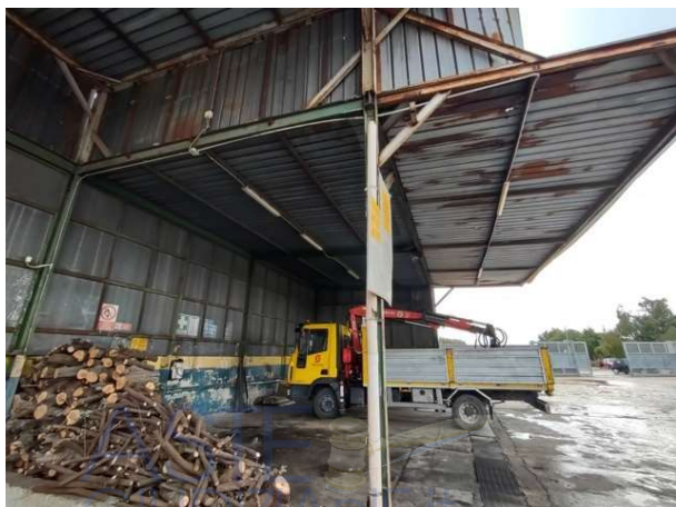
Foto 13: Particolare Edificio 1 (Vista verso Sud)
