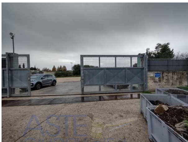
Foto 7: Particolare cancello dall'interno verso Sud
