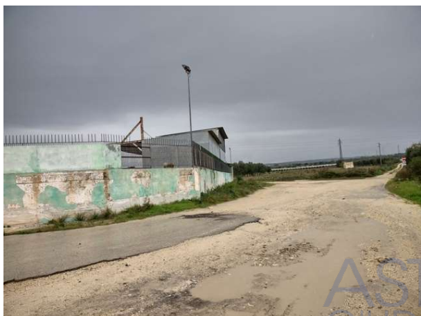
Foto 3: Muro di cinta lati Sud e Sud-Est
