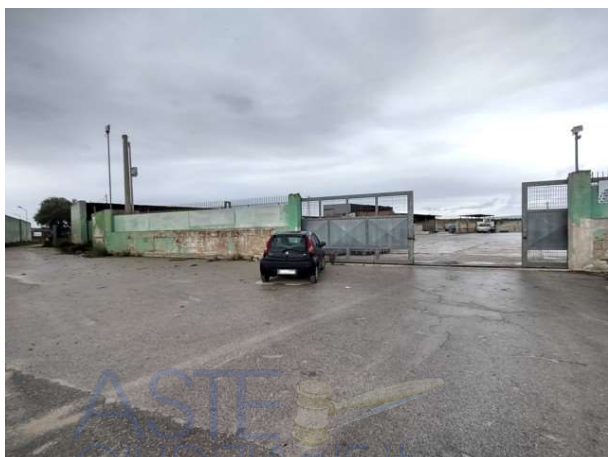
Foto 1: Cancelli e muro di cinta verso NO
