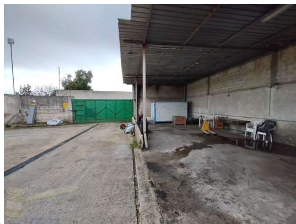
Foto 28: Interno Edificio 5 (vista verso Sud)
