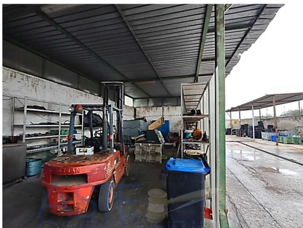
Foto 19: Interno Edificio 2 (Vista verso Nord)
