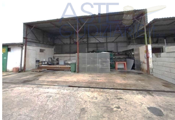
Foto 20: Edificio 3 (Vista verso Ovest)
