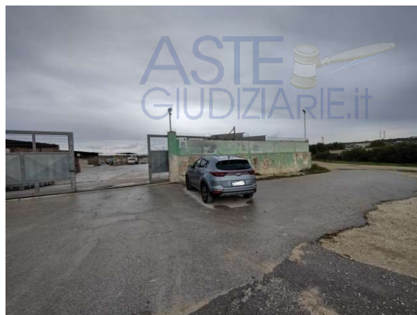
Foto 2: Cancelli e muro di cinta verso NE
