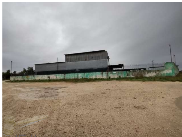
Foto 4: Muro di cinta lato Sud-Est
