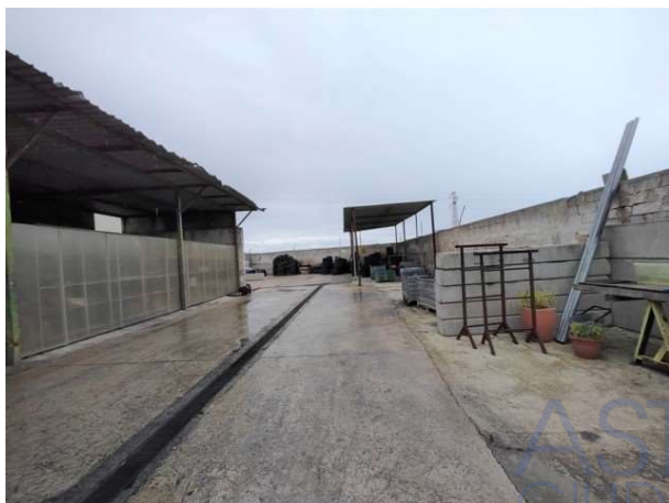
Foto 15: Particolare piazzale (angolo a NE)
