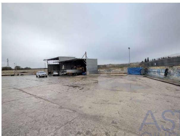
Foto 9: Piazzale ed Edificio 1 (Vista verso Est)
