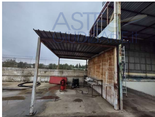
Foto 14: Particolare Edificio 1 (Vista verso Est)
