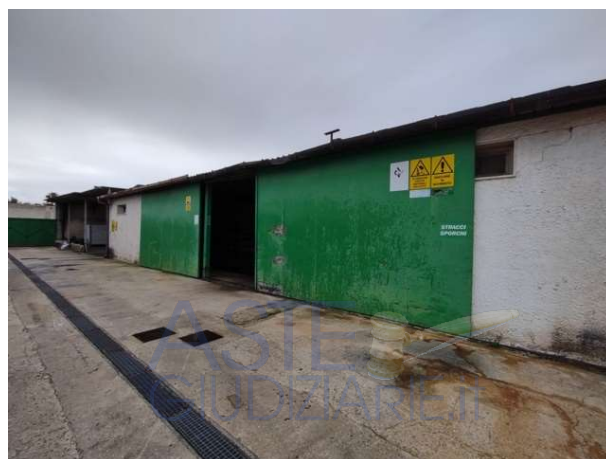
Foto 24: Edificio 4 (Vista verso SO)
