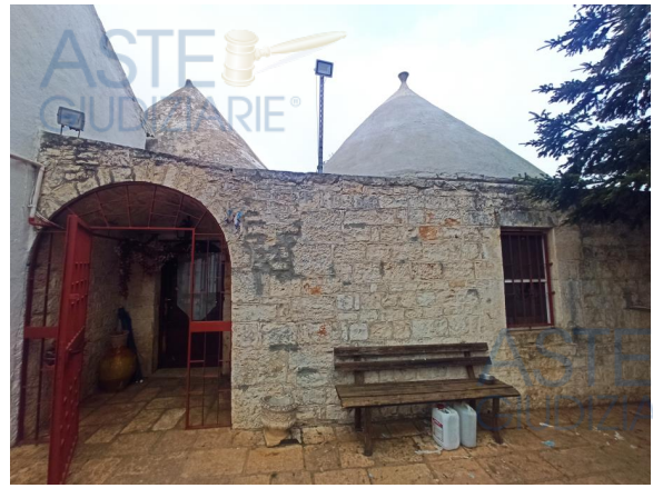
Foto n.2 - Particolare esterni con ingresso
