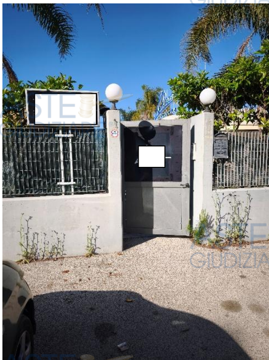
Fig. 5) Foto dell'accesso principale alla struttura
