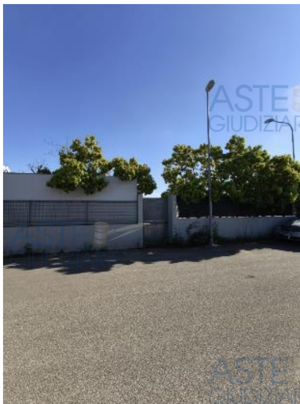
Fig. 6) Accesso pedonale da Via Noci di Cocco
