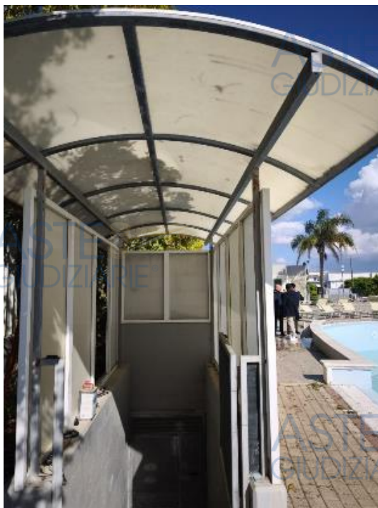
Fig. 33) Struttura metallica con pannelli e pensilina che copre la scala di accesso al vano tecnico
