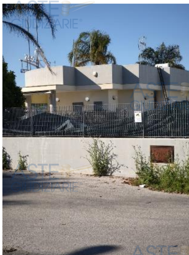
Fig.11) Struttura bar ed ufficio vista dall'esterno
